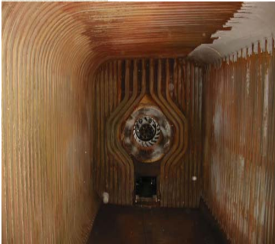
CONTROLLO CAMERA DI COMBUSTIONE GENERATORE A TUBI DI ACQUA
