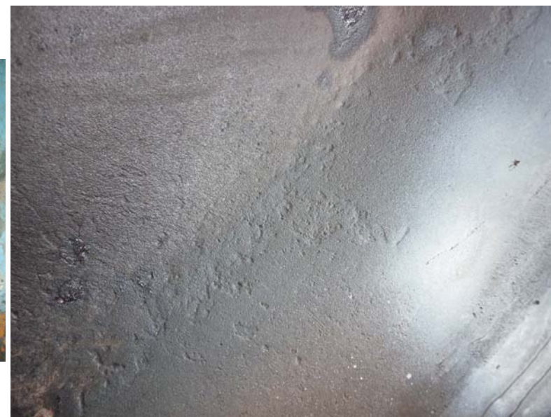
CORROSIONE DIFFUSA
